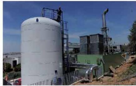
Έναρξη λειτουργίας συγκροτήματος αναπαραγωγής ηλεκτρικής ενέργειας και θερμότητας (ΣΗΘΥΑ). Ενεργειακή αυτονομία του νοσοκομείου σε ποσοστό  $\geq 65\%$
